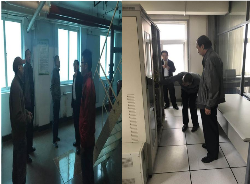
对泵房和网络机房进行全面检查，防止各类隐患发生
